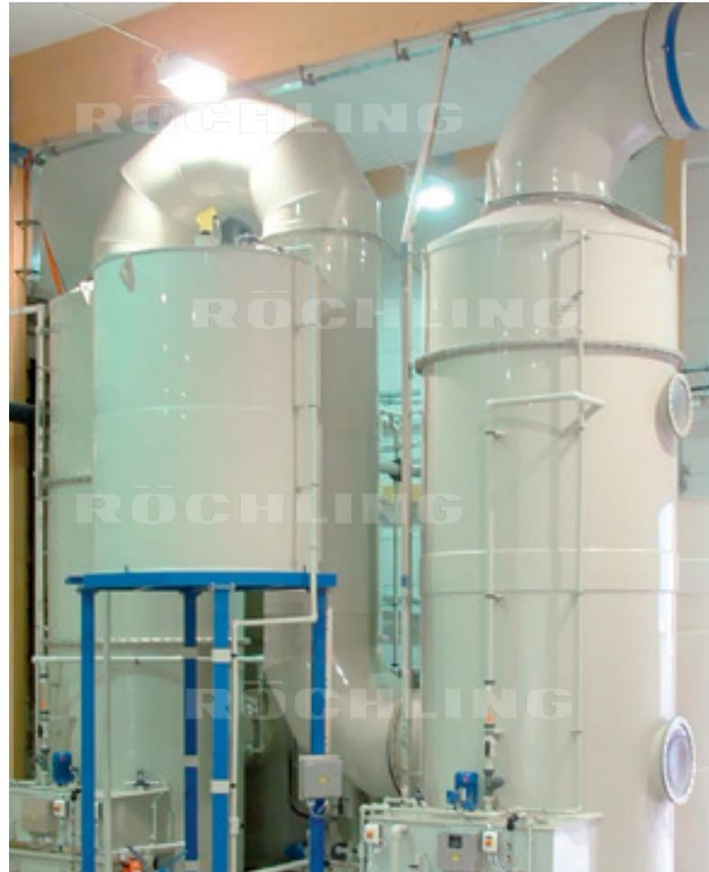
Frecuentemente, los líquidos utilizados en instalaciones de extracción y lavado de gases son fuertemente corrosivos. Se utilizan materiales termoplásticos debido a su particular resistencia a la corrosión.
