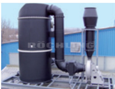
Polystone® PPs EL nero Torre di abbattimento
