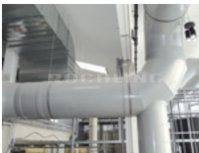
Polystone® PPs grigio Impianto di aerazione
