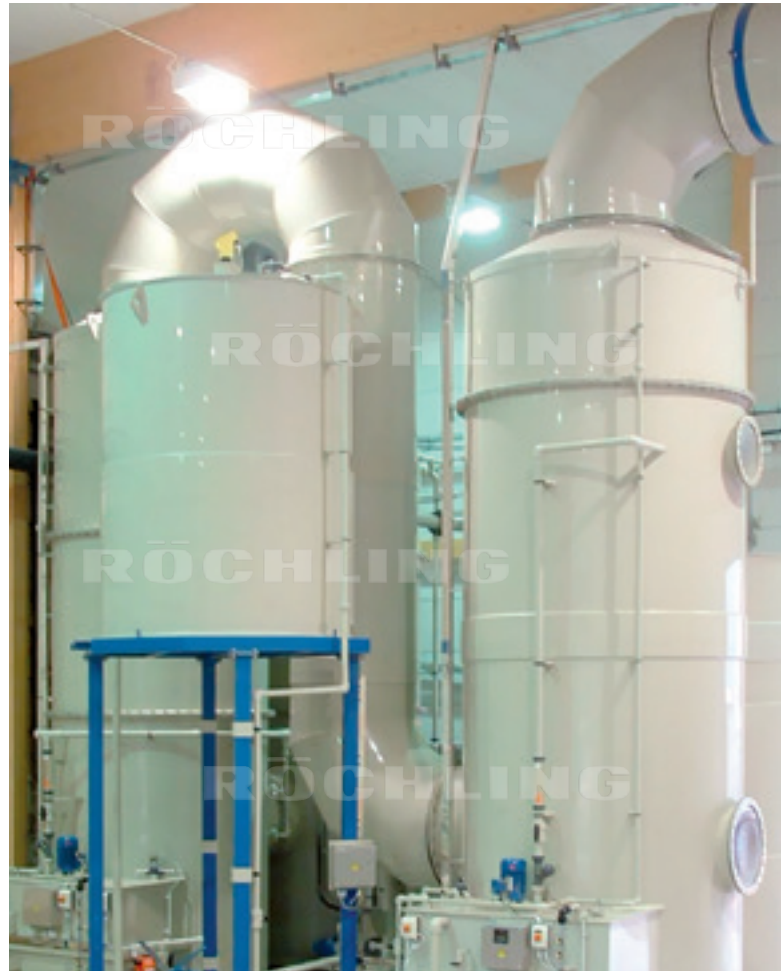
Die in Abluftreinigungsanlagen verwendeten Flüssigkeiten und Gase sind häufig stark korrosiv. Aufgrund ihrer besonderen Korrosionsbeständigkeit kommen thermoplastische Kunststoffe zum Einsatz.
