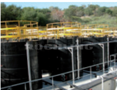
Polystone® G schwarz B 100-RC Lagerbehälter für Salzsäure
