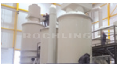
Gaswäscher einer Biogasanlage aus Polystone® P Homopolymer grau
