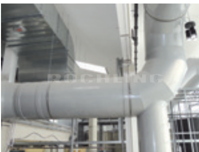
Polystone® PPs grau Lüftungsanlage
