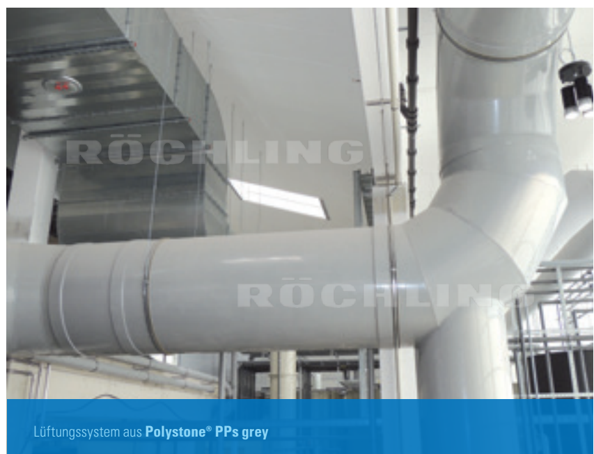
Polystone® P Homopolymer grau Lüftungssystem für eine Galvanikanlage
