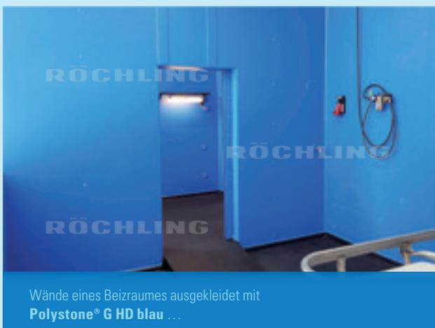
Wände eines Beizraumes ausgekleidet mit **Polystone® G HD blau** ...
