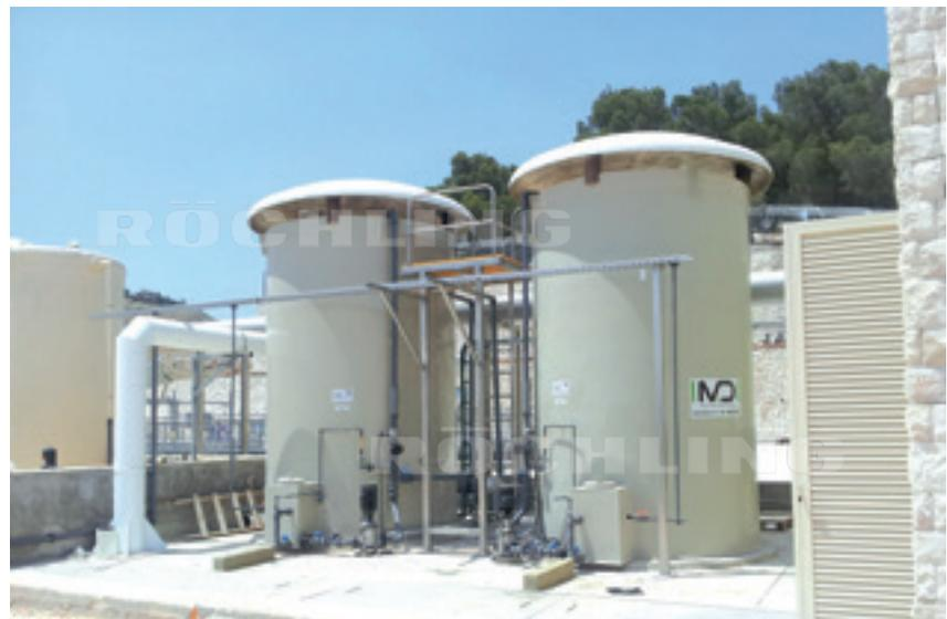
Biofilter zur Geruchsneutralisation
