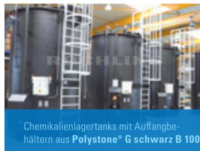
Chemikalienlagertanks mit Auffangbehältern aus **Polystone® G schwarz B 100**
