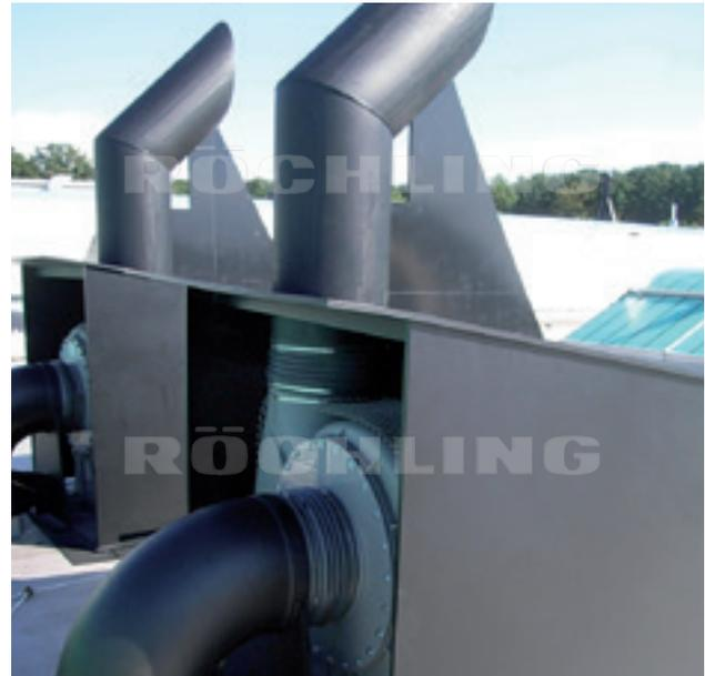
**Polystone® G HD schwarz** Einhausung einer Lüftungsanlage auf einem Hallendach. Hier ist eine gute Witterungsbeständigkeit zwingend erforderlich.
