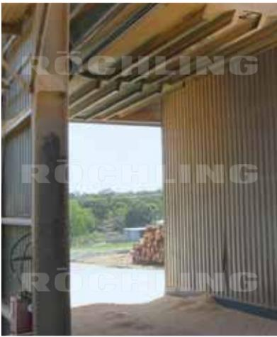
Blick von unten in einen Bunker: Bei großkörnigen Schüttgütern, die zu partiell starkem Verschleiß führen, können bereits Teilauskleidungen mit Matrox® die Lebensdauer des Bunkers deutlich erhöhen.
