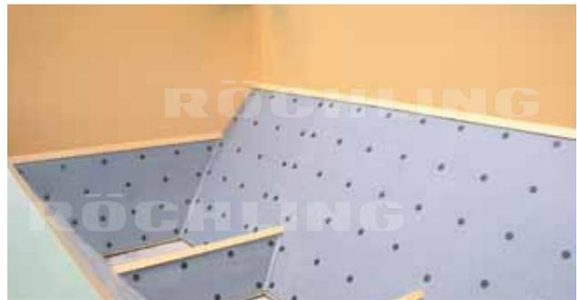
Bunkerauskleidung mit „Weld washern“: Deutlich ist die Verteilung der Befestigungspunkte zu erkennen.
