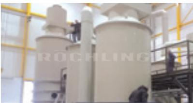
Lavador de gases en una planta de biogás de Polystone® P Homopolímero gris
