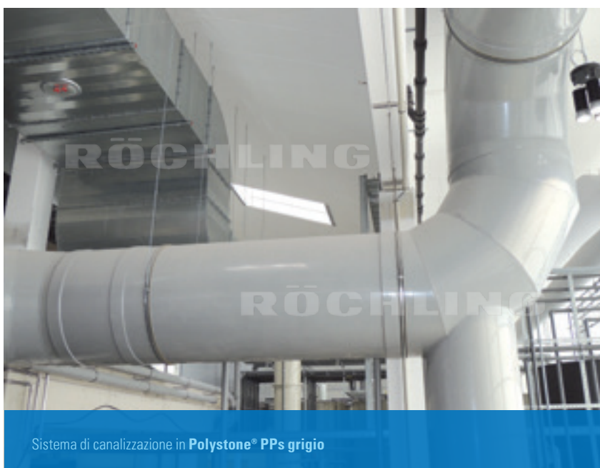
Polystone® P omopolimero grigio Sistema di aerazione di un impianto galvanico
